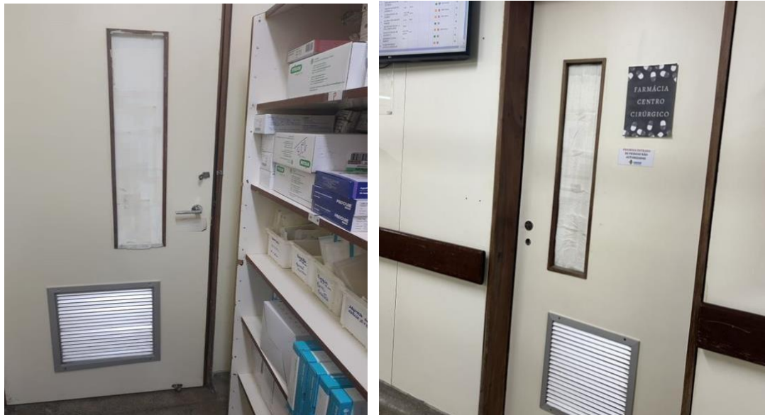
Porta de acesso à farmácia que se encontra aberta
