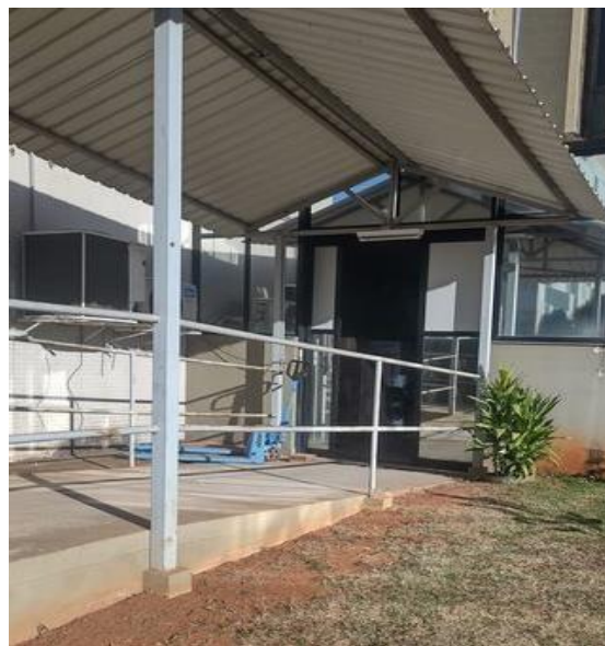
Porta de entrada da dispensação de material
